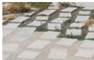
Pavés béton transition avec joints végétalisés
