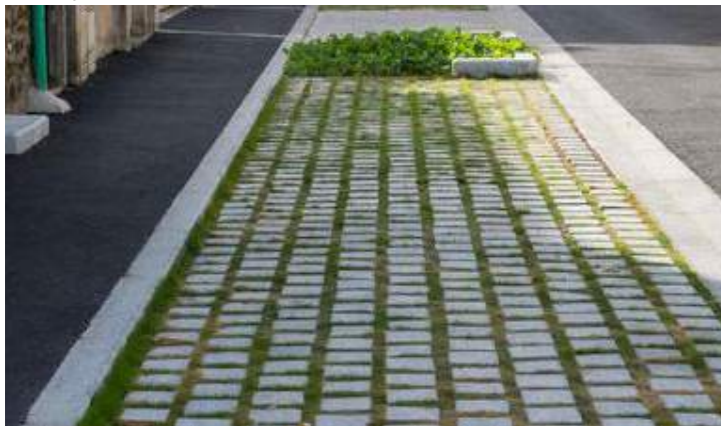
Stationnement avec pavé à joints végétalisés
